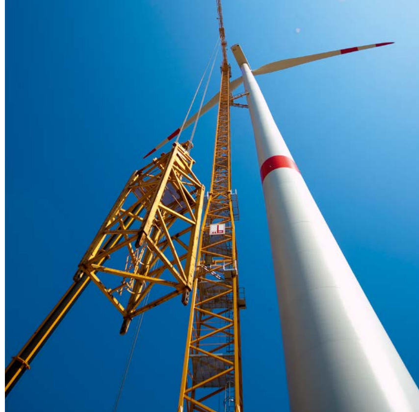
Turmstücke lassen den Kletterkran gemeinsam mit der Windenergieanlage in Höhen von über 150 m wachsen.
