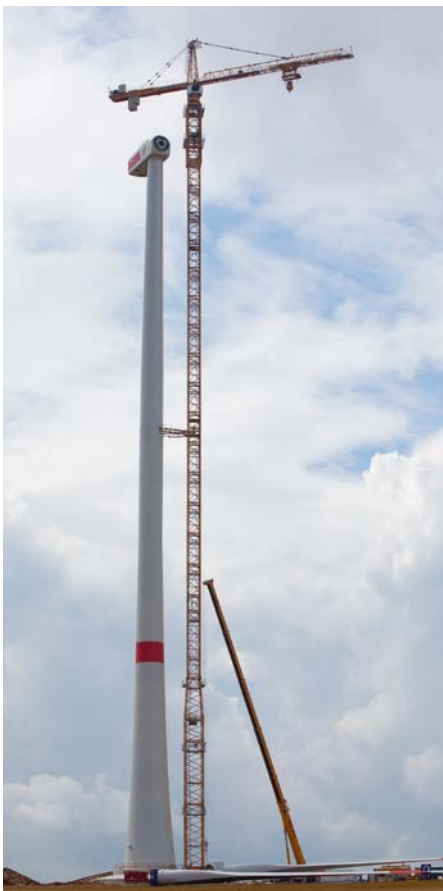
Turmstücke lassen den Kletterkran gemeinsam mit der Windenergieanlage in Höhen von über 150 m wachsen.
