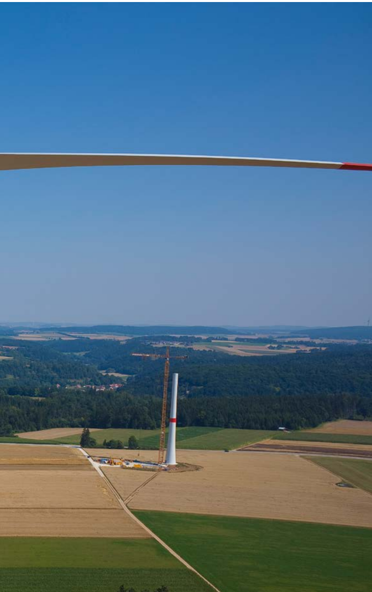
Auf einer Fläche von rund 10.200 m 2 fangen die sechs leistungsstarken Kraftwerke Wind ein und wandeln diesen in Stromenergie um.
