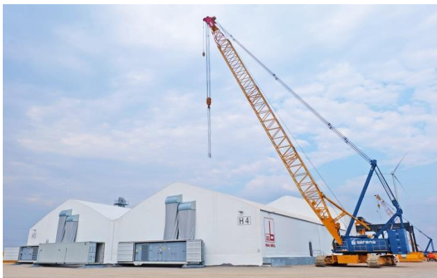
Besteht aus vier Hallen: die Mobile Fertigung der Max Bögl Wind AG. Bildquelle: Max Bögl Wind AG/Reinhard Mederer
