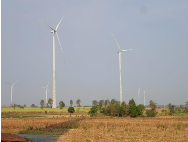
Erstes Projekt erfolgreich umgesetzt: Hybridtürme der Windfarm Thepharak. Bildquelle: Max Bögl Wind AG
