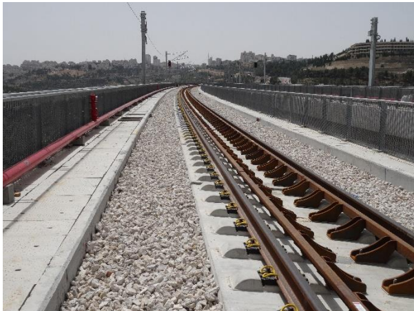
Bild 2) 133.616 Feste Fahrbahn Bögl auf der Brücke vor Jerusalem; Bahnroute von Tel Aviv nach Jerusalem. Bildnachweis: Firmengruppe Max Bögl
