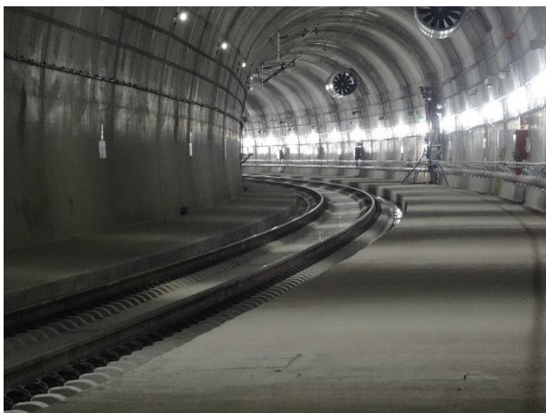
Bild 3) 133.615 Einsatz der Festen Fahrbahn Bögl im Tunnel. Bildnachweis: Firmengruppe Max Bögl
