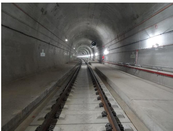
Bild 4) 133.617 Einsatz der Festen Fahrbahn Bögl im Tunnel. Bildnachweis: Firmengruppe Max Bögl
