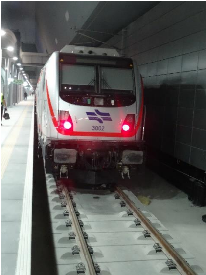
Bild 5) 133.614 Hochgeschwindigkeitsstrecke mit Fester Fahrbahn Bögl im Bahnhof Jerusalem. Bildnachweis: Firmengruppe Max Bögl
