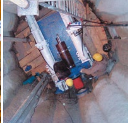
Bohrungen Horizontaldrains, U3/3 München
