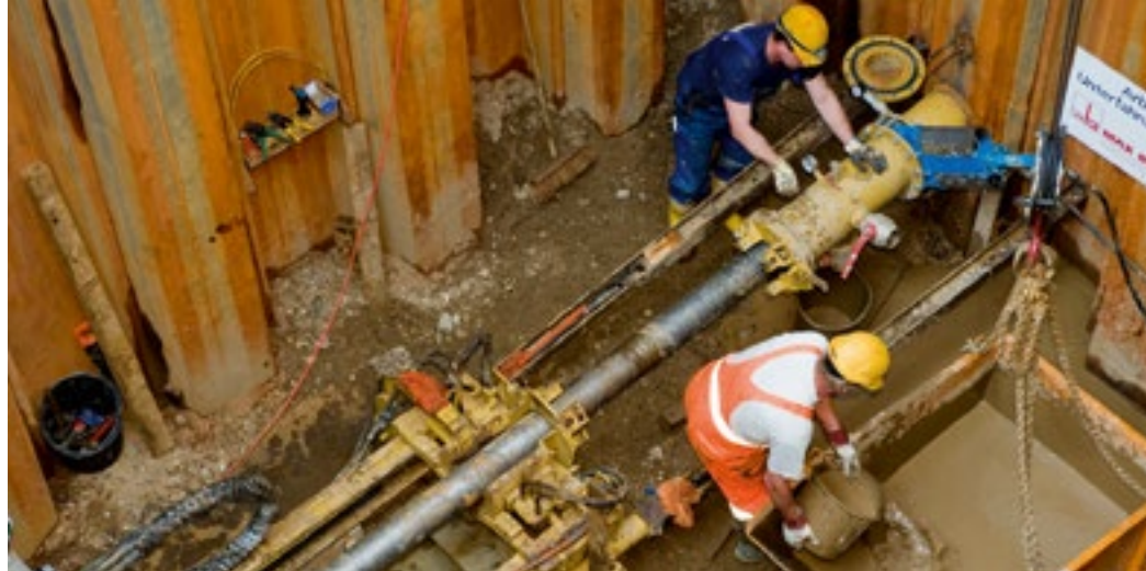
Pilotbohrungen U-Bahn Wehrhahn-Linie, Düsseldorf
