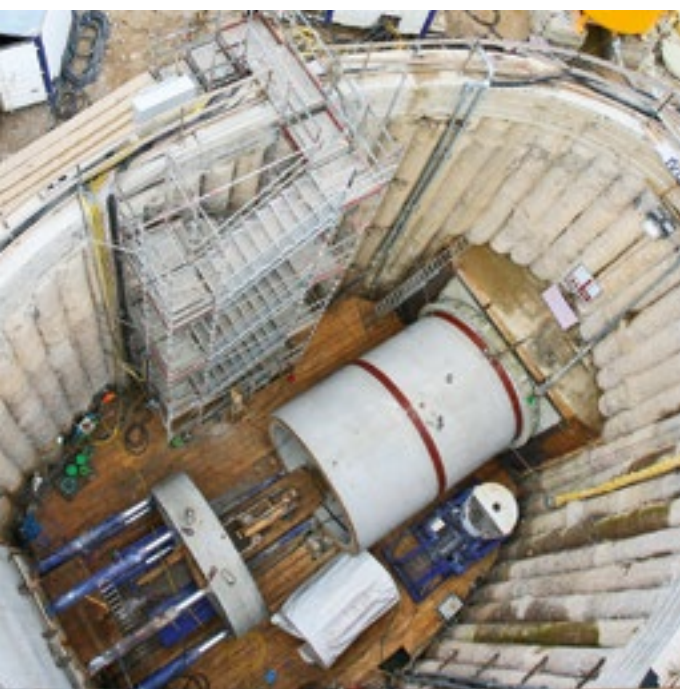
Südotsammler BA4, Nürnberg (oben), Startschacht Wesseling, Tunnel Trasse Ost (unten)
