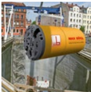
Verlängerung des Südostsammlers, Nürnberg
