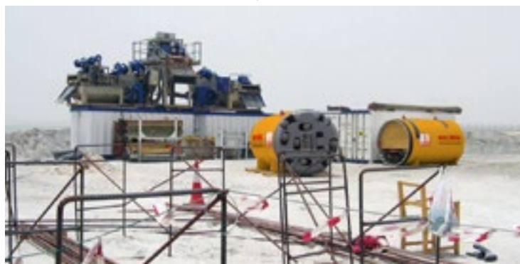
Vollschnittmaschine und Separieranlage, Katar
