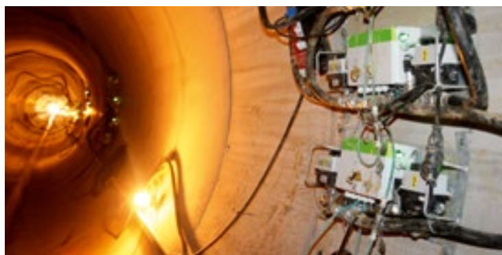
Bentonitventilanordnung bei Großrohren
