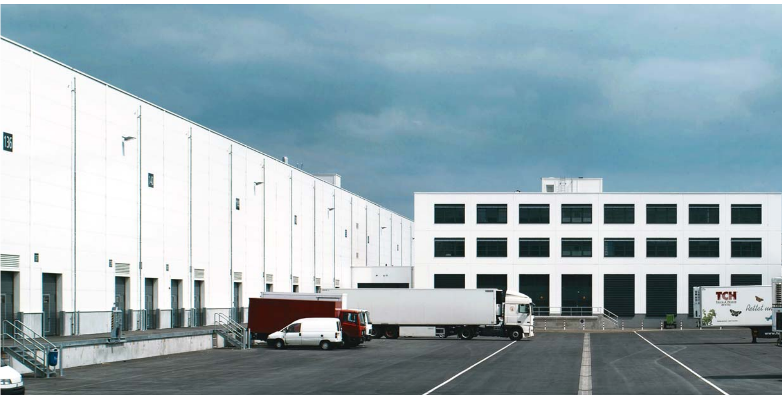
Rampen an den einzelnen Verkaufsflächen garantieren kurze Be- und Entladezeiten.
