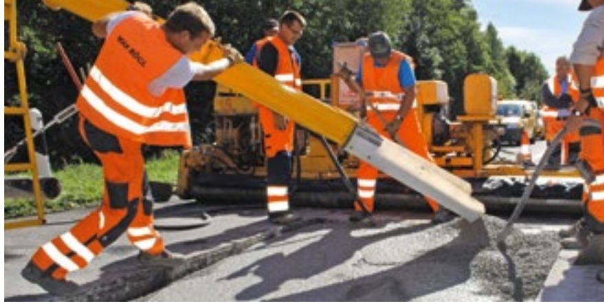
Am Einsatzort muss nur noch das vorverwogene Anmachwasser zugegeben und der Schnellbeton fertiggemischt werden.
