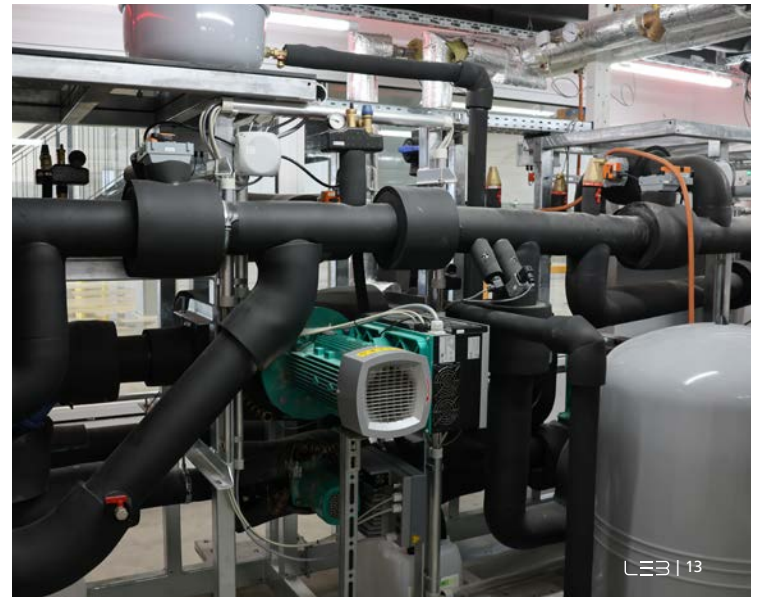
Die Hydraulikstation kann sowohl im Gebäude als auch in einer separaten Technikzentrale untergebracht werden.
