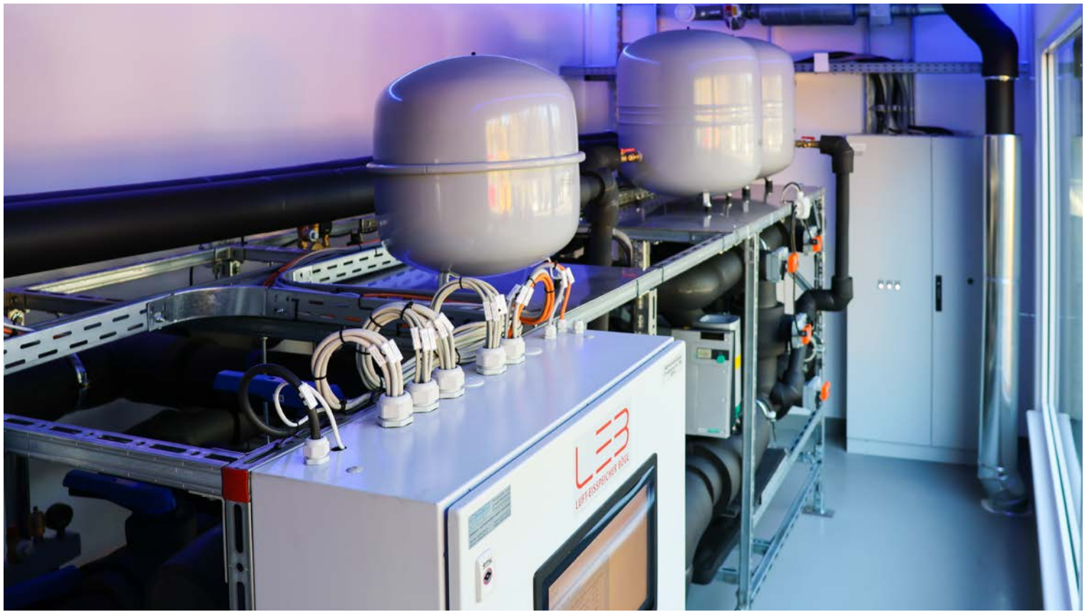
Die Hydraulikstation kann sowohl im Gebäude als auch in einer separaten Technikzentrale untergebracht werden.
