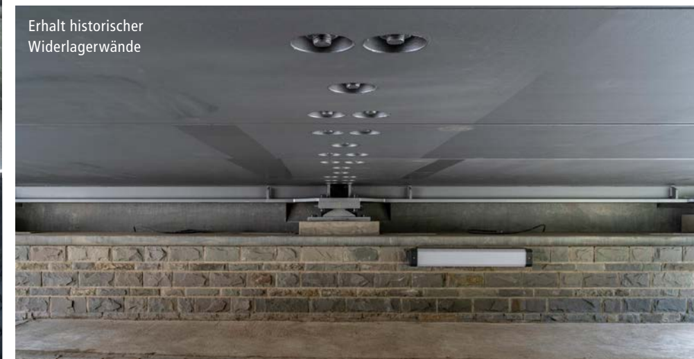
Stützweite unter 15 m und Gleisabstand 3,85 m im Radius
