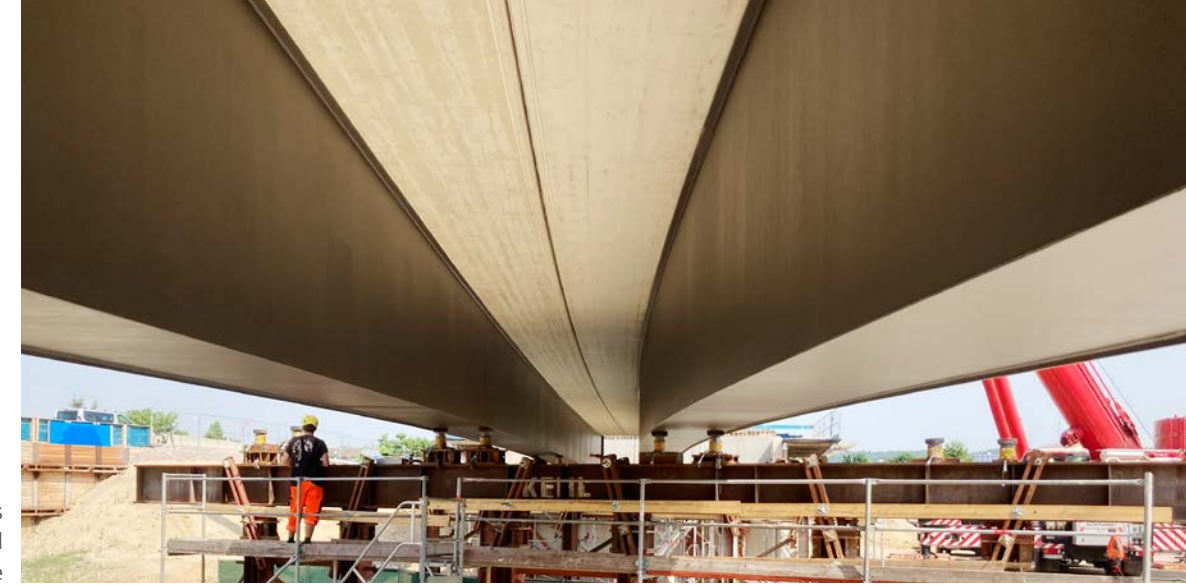
Montage des Verbundträgers Bögl auf der Baustelle
