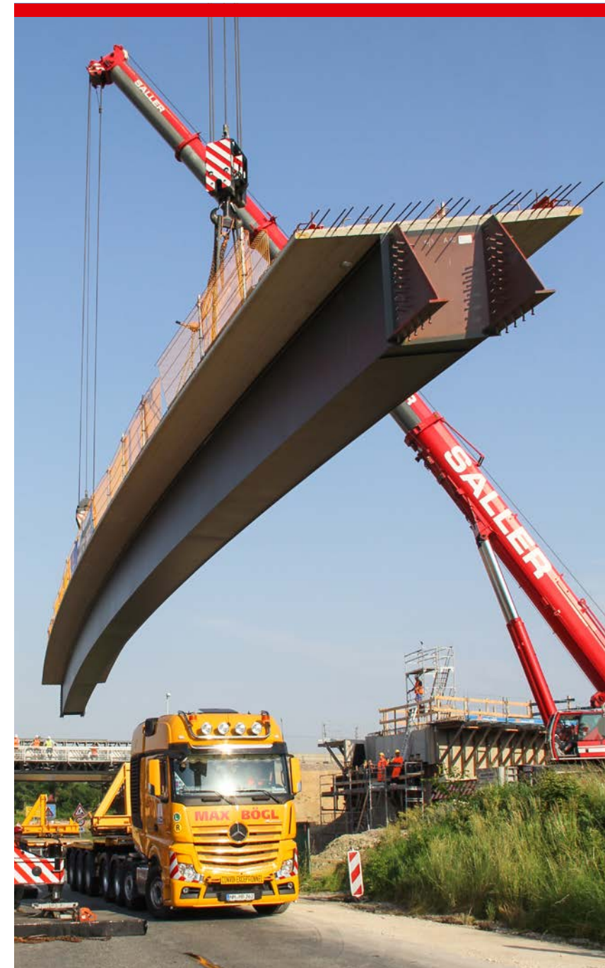
Trägereinhub auf der Baustelle mit Autokranen
