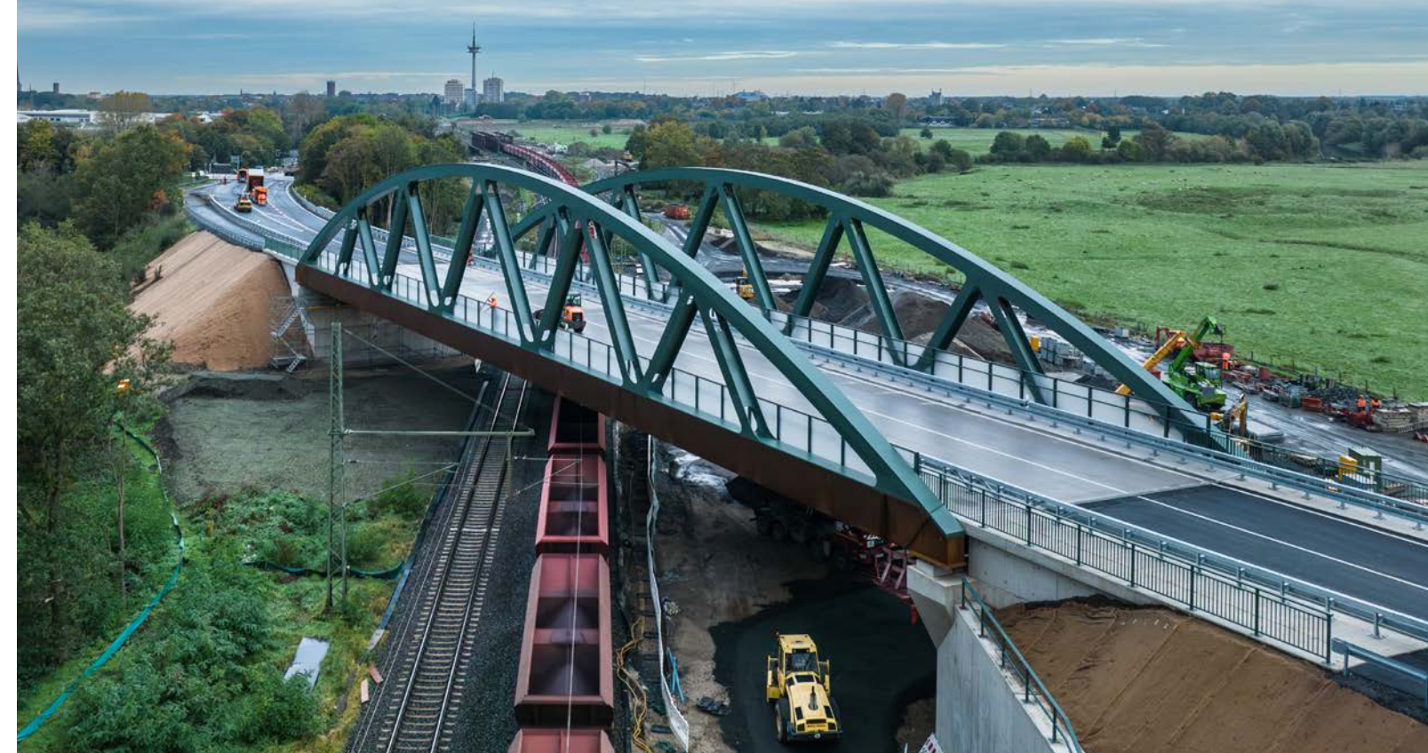
Ausführung mit oben liegendem Tragwerk
