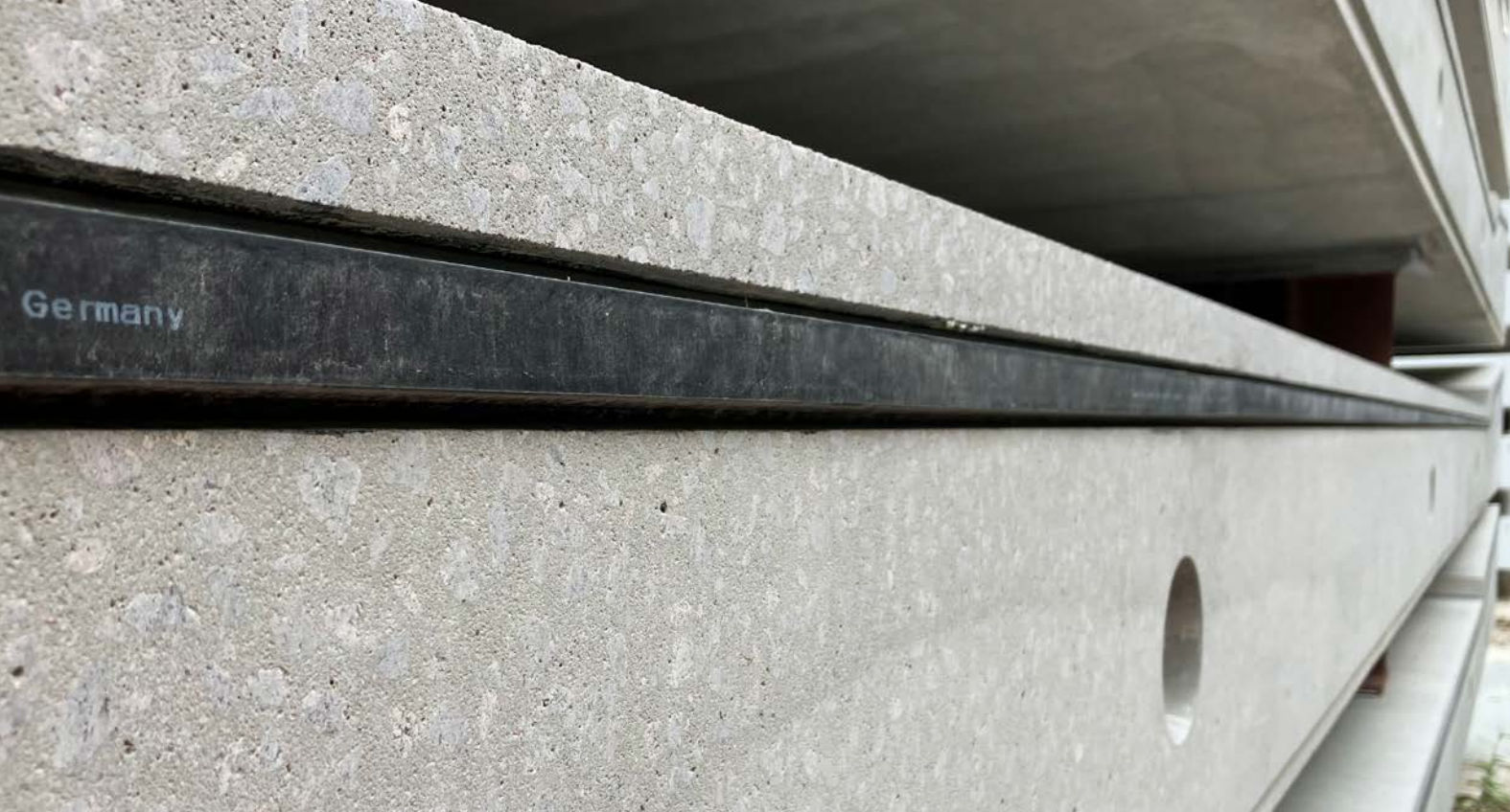
Kontaktflächen der Fahrbahnmodule
