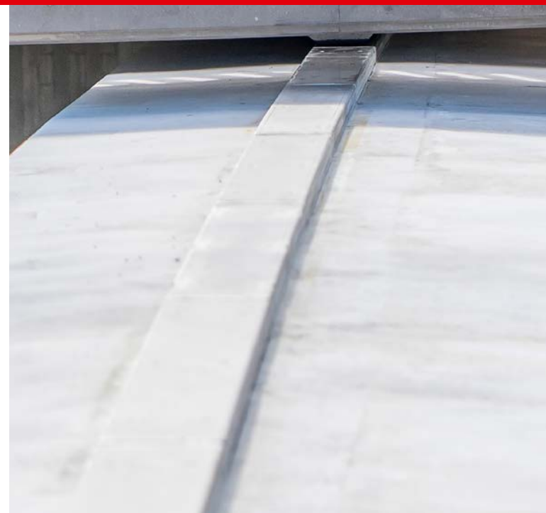
Auflagerung der Modulplatten auf den Längsträgern
