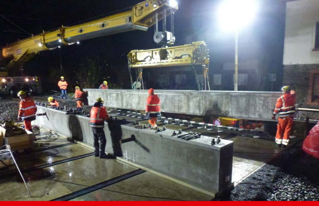
Einbau der Hybriden Bahnbrücke Bögl in Sperrpause
