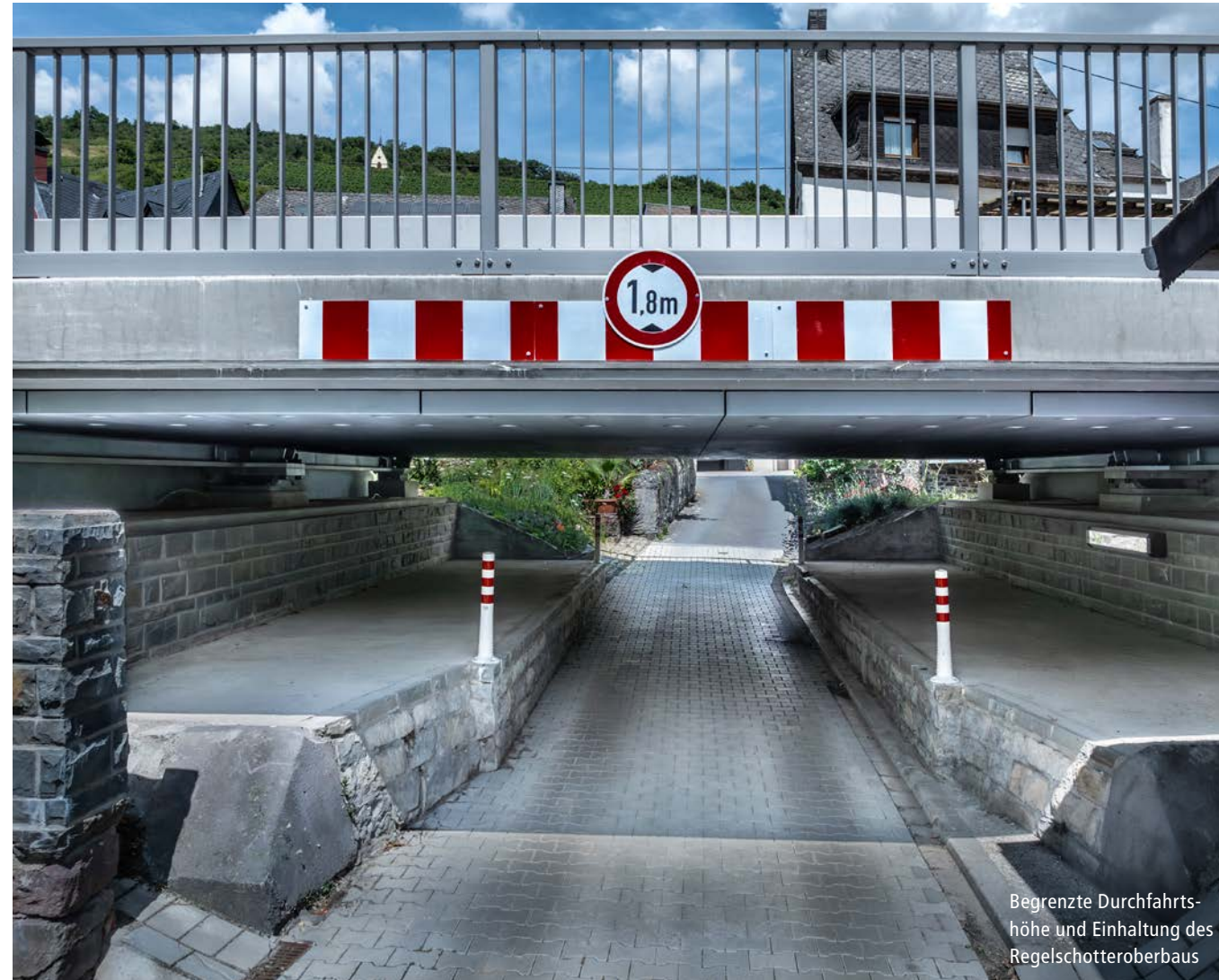
Stützweite unter 15 m und Gleisabstand 3,85 m im Radius
