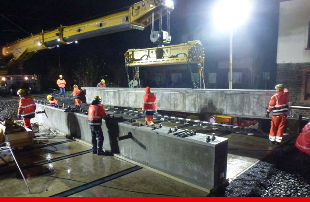
Einbau der Hybriden Bahnbrücke Bögl in Sperrpause
