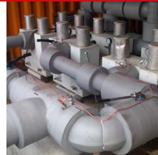
Construction d'installations et de pipelines
