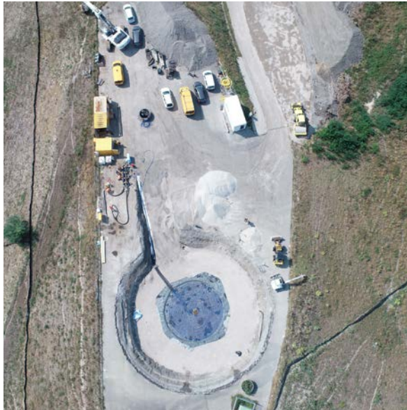
Soutien de la fondation sur un site d'enfouissement
