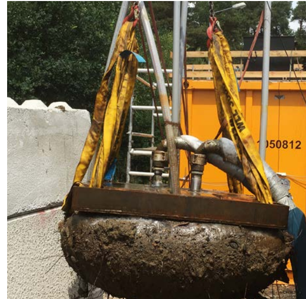
Récupération de substances contaminées en provenance des cours d'eau
